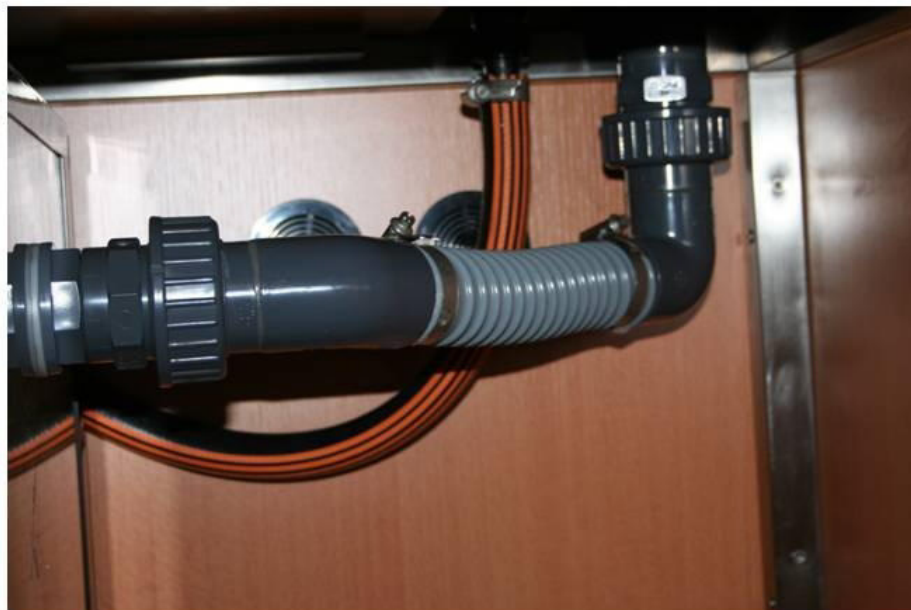
Figura 2: Installazione dei raccordi dello scarico. Il tubo a strisce posteriore è il tubo flessibile che connette l'Eco Runner 3700 all'estremità inferiore del tubo della tubatura rigida di 25 mm del connettore della vasca.
